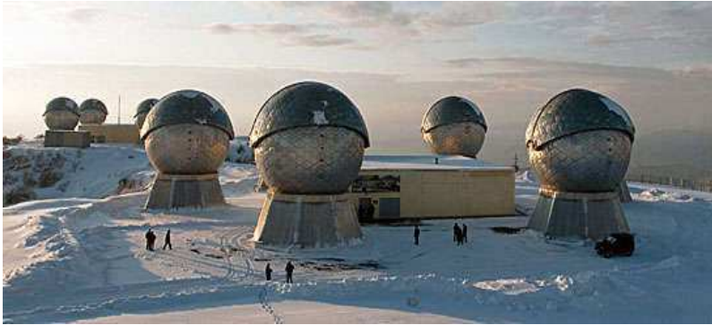
Рис. 2.136 – Оптико-електронний комплекс “Окно”
