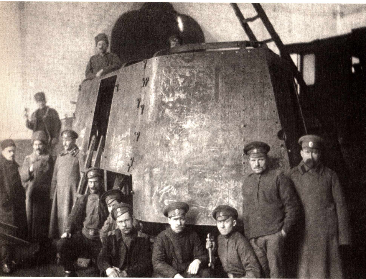
Будівництво панцирної дрезини у майстернях Київського політехнічного інституту під час Першої світової війни.
