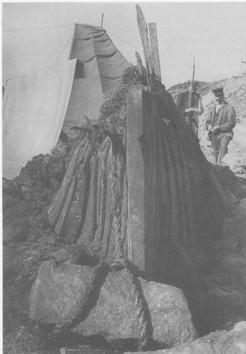
Рис. 10. Форштевень корабля привязан к каменному блоку (по Osebergfundet I, fig.31)
