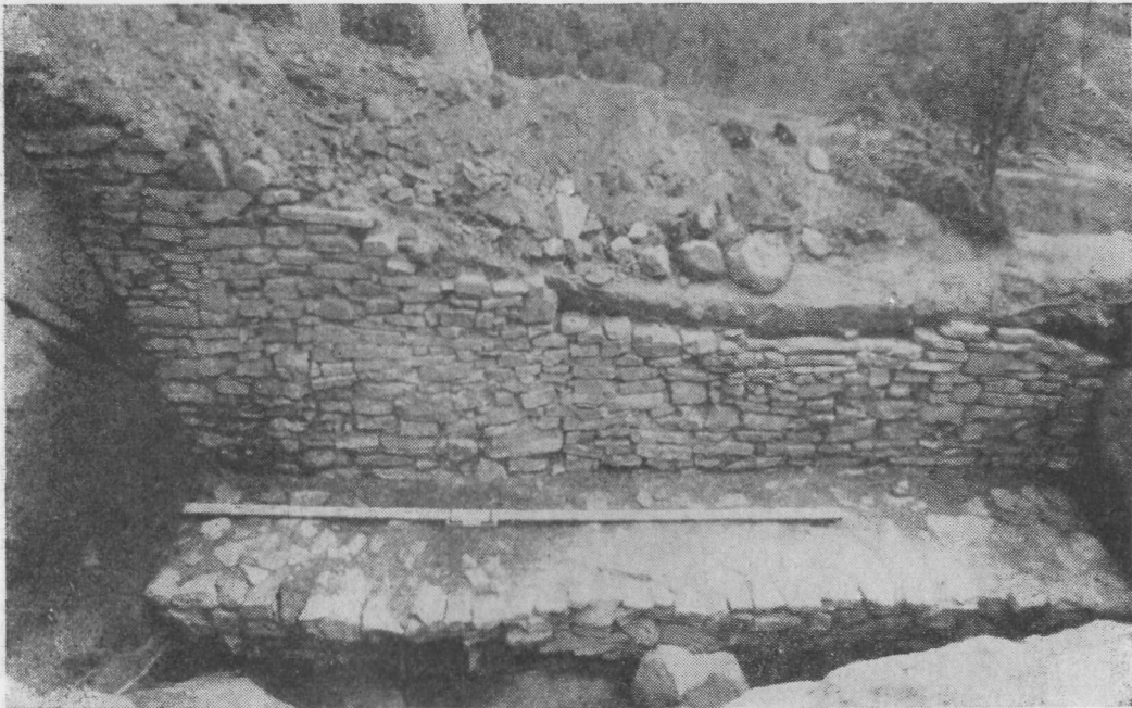
Рис. 16. Східний бік кам'яної кладки південної оборонної стіни. Вигляд з півночі. На передньому плані фундаментна подушка. Фото автора.
