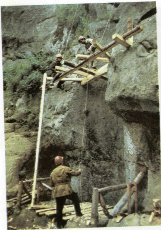
45. Криниця. Встановлення дерев'яних конструкцій по наявних слідах в шахті криниці. Вигляд з південного заходу. Фото автора.
