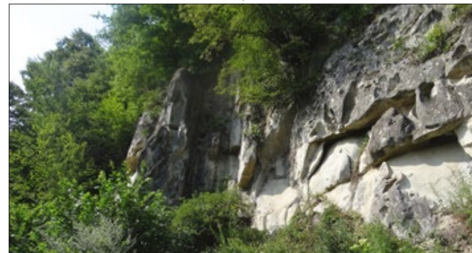
Fig. 4.26. Formy wietrzenia na powierzchni skalnej ściany w Myczkowcach
