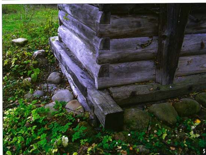
Рисунок 5 Село Пістинь, соляне джерело-криниця в Горішньому Куті. Частина дерев'яного цямриння криниці. Вигляд з північного заходу
