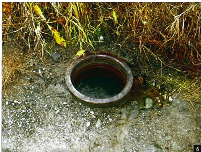
Рисунок 6 Село Рунгури, соляні джерела. Ділянка з двома кадубами. Кадуб з азбоцементної труби. Вигляд з південного заходу
