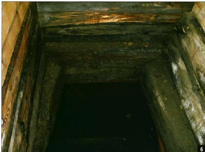
Рисунок 6 Село Уторопи, внутрішній вигляд дерев'яного цямриння соляної криниці (шахти) Уторопи I
